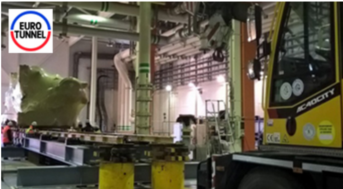
運送 CenTraVac™ 冷水機組到英法隧道現場的盛況。
